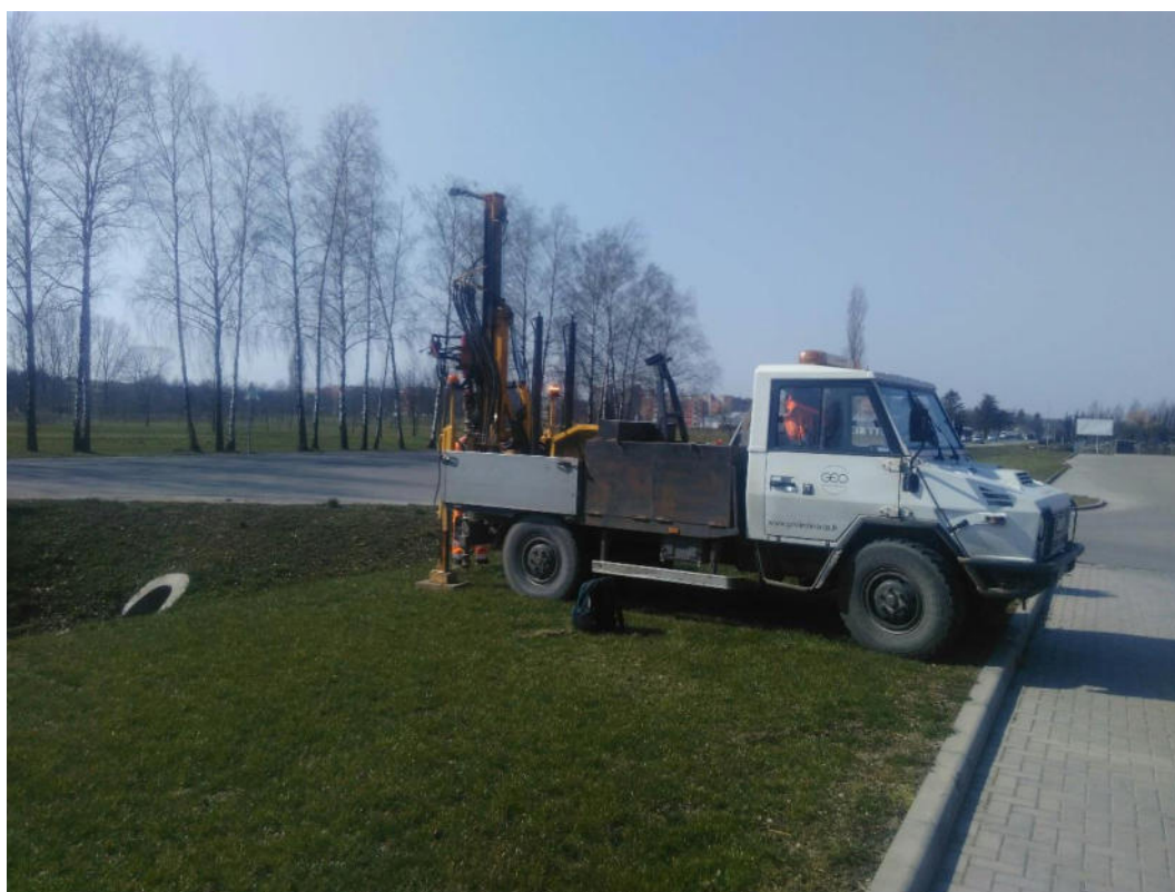
1 pav. Lauko darbai
